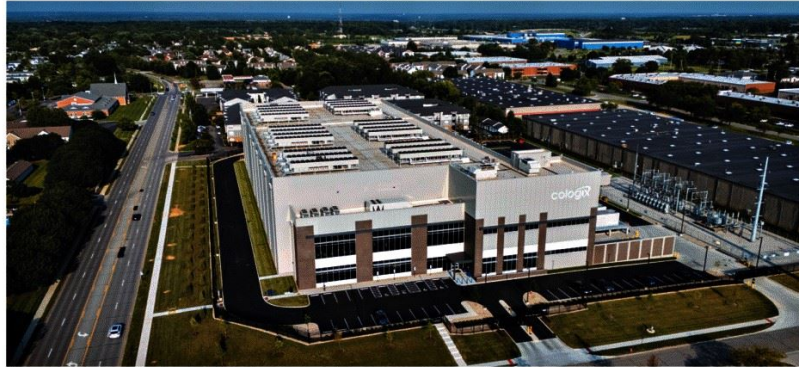
미국 오하이오주 컬럼버스에 들어선 인공지능(AI) 특화 데이터센터 전경(왼쪽). 부지 면적만 약 2만8000㎡에 달하며, AI 개발에 필요한 막대한 전기 사용량을 고려해 전력 용량도 50메가와트(MW)에 달한다. 오른쪽 사진은 LG CNS가 인도네시아 자카르타에 건설 중인 11층 규모 데이터센터 조감도다. 이곳에는 LG전자와 LG에너지솔루션의 냉각·배터리 기술이 적용된다.
