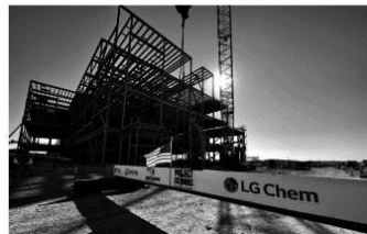
LG화학 테네시 양극재 공장 건설현장. G화학 제공
